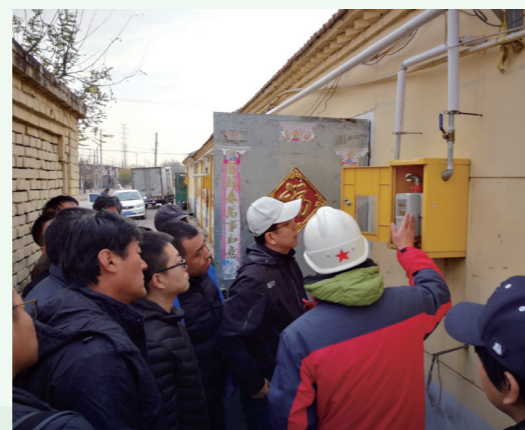
“煤改气”工程施工调试现场
