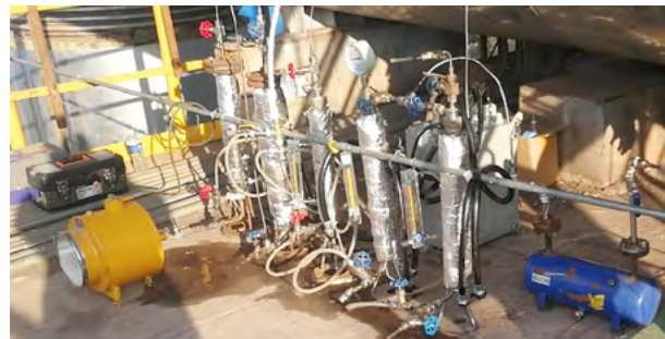
武安工业区试验现场
